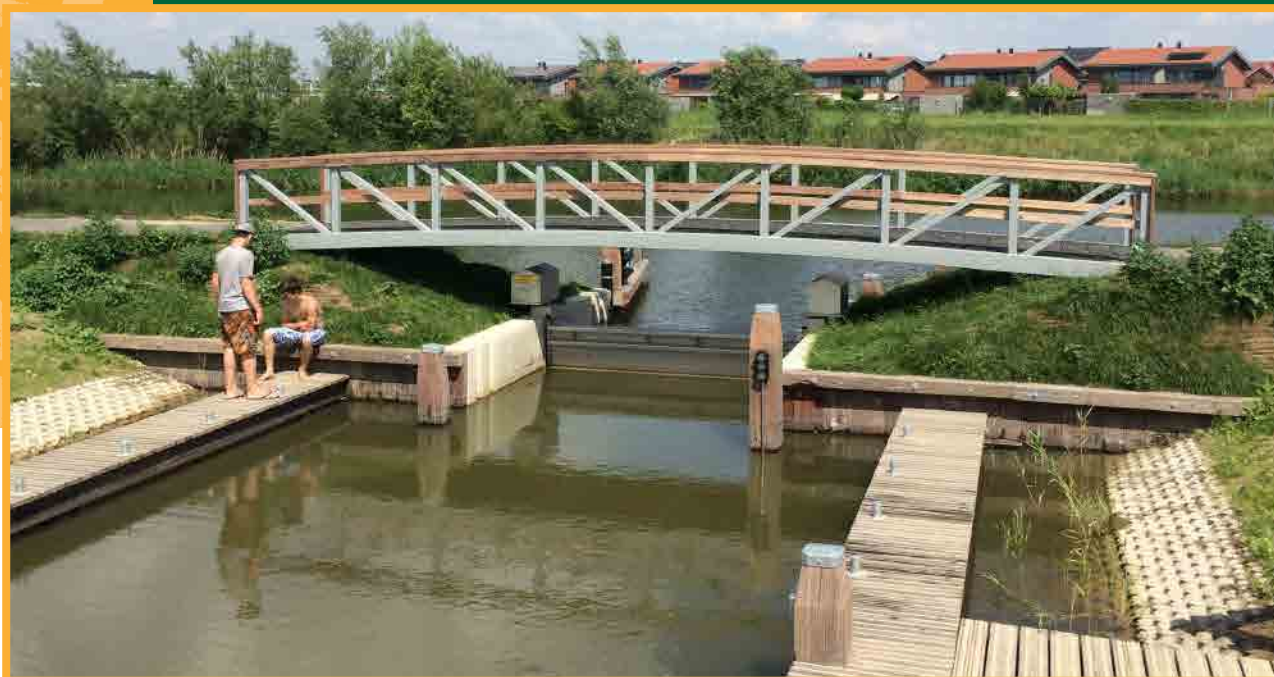
Aanleg Recreatiesluis Koedood, Albrandswaard (D&C)
